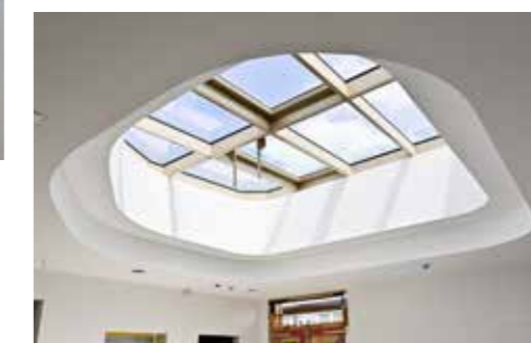
Ein architektonisches Highlight: Das Oberlicht, das für natürlichen Lichteinfall im Haupttreppenhaus sorgt.
